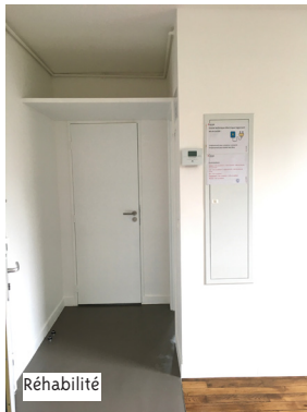
Entrée (création d'un range valise et encastrement de la GTL)
