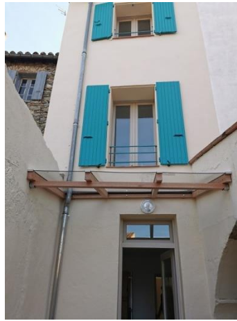
Photos après travaux
